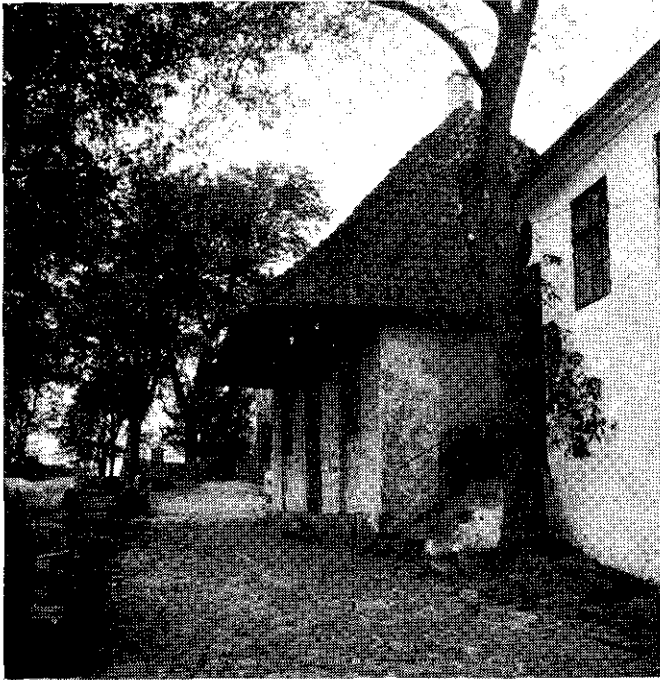
Fig. 19. Hovedvagten (Infanterivagten) havde stue for officerer til venstre, for mandskabet til højre. Under det fremspringende tag gik skildvagten. Før 1767 lå bygningen nærmere havnen. (fot. Eva Bunch). Til venstre ses Paradepladsen, til højre Forvalterboligen.
